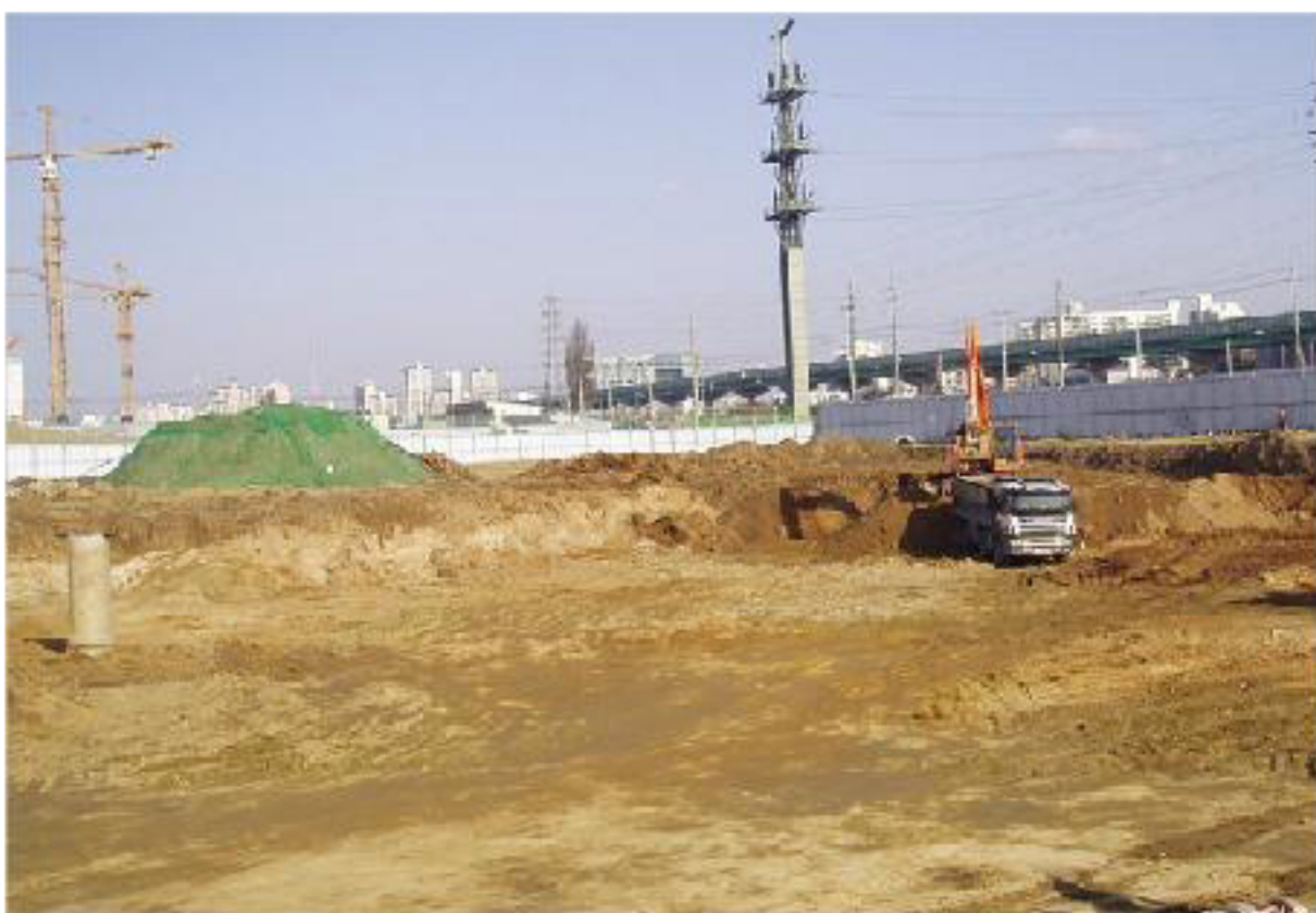
▲ 광명 SK 신축공사현장_SK건설
